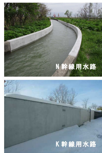
Fig.5 試験施工の状況 Test construction
